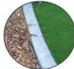
E Concrete edge beam (balance)
